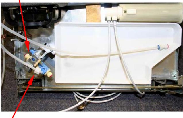
**Etape 2 :** Retirer l'écrou de connexion de l'entrée d'eau de l'électrovanne
